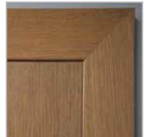
łączenie opasek pod kątem 45°
