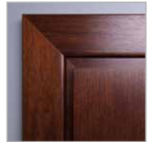
łączenie opasek pod kątem 45°
